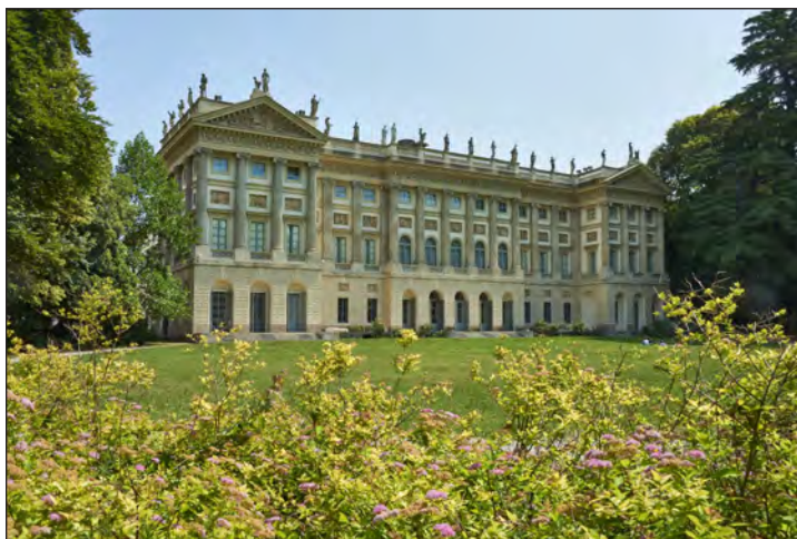
Esterni e parco. La Villa Reale, progettata da Leopoldo Pollack in stile neoclassico, si affaccia su un ampio giardino all'inglese. (Copyright Comune di Milano – tutti i diritti riservati - Galleria d'Arte Moderna, Milano / Aleph, Como)
