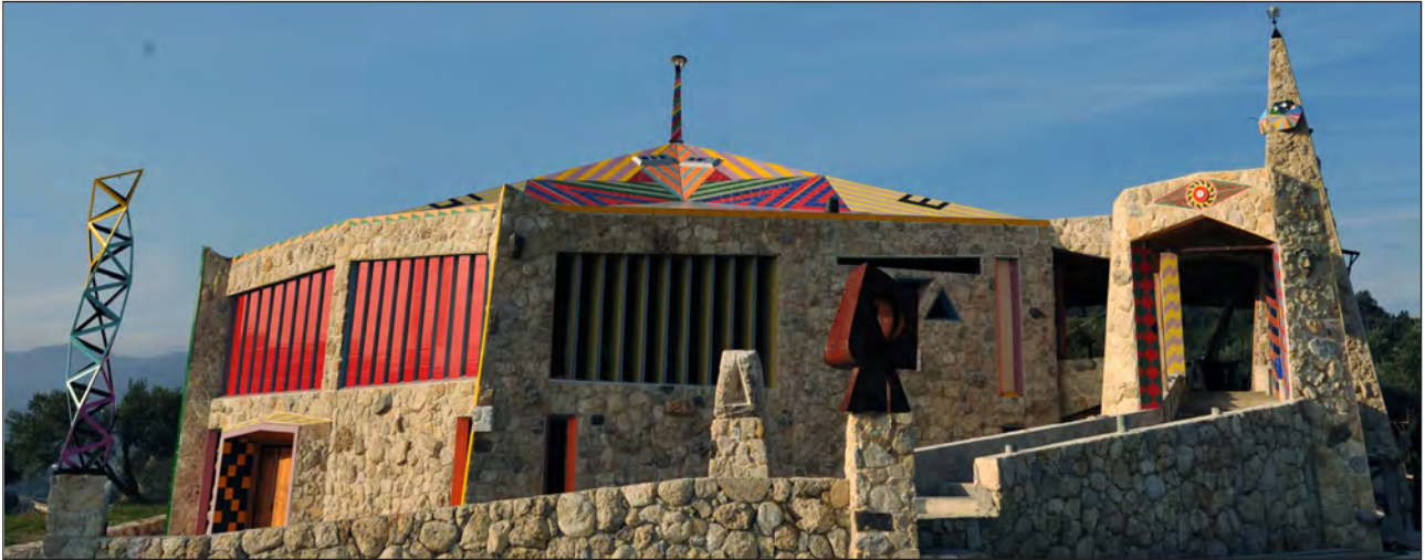
L'edificio della Rosa dei Venti interamente realizzato da Nik Spatari tra il 2008 e il 2013. (© MuSaBa)
