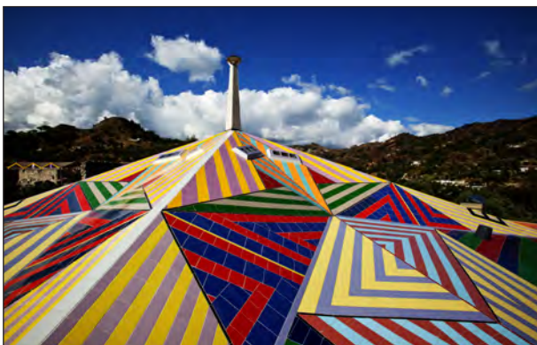
Un dettaglio della copertura della Rosa dei Venti. (© MuSaBa)
