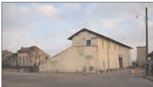
Figura 3 - Un'immagine della struttura restaurata. (Foto G. Perani)
