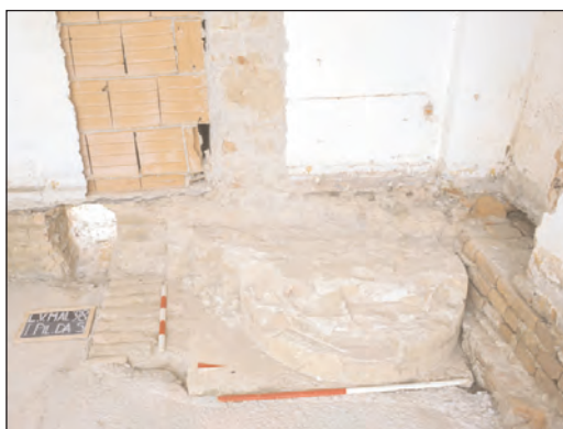
Figura 4 - Interventi di restauro al Conventino: una base delle colonne della cattedrale romanica lasciate a vista nel progetto di recupero e valorizzazione della struttura. (Foto AFS)
