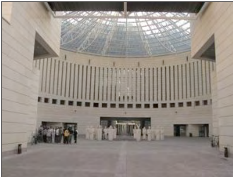
Figura 5 - Il cortile di ingresso del Museo d'Arte Moderna e Contemporanea di Trento e Rovereto (MART), progetto di Mario Botta. (Foto Nuova Museologia)
